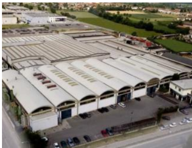
Una veduta dall'alto della sede di Prevalle della Industrie Pasotti spa
